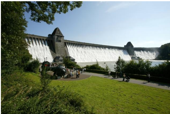
Hochwasserüberlauf an der Mohnestaumauer
