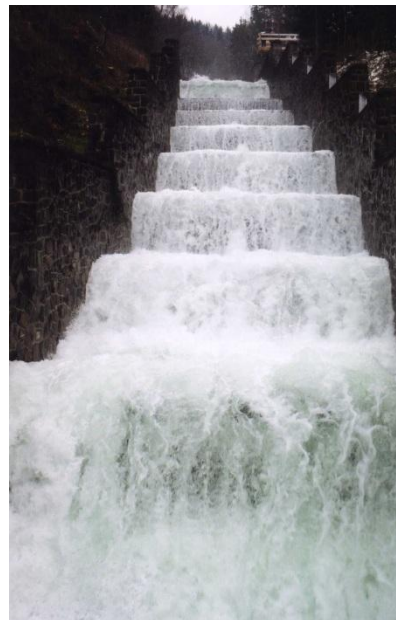
Abflussgerinne am Sorpedamm
