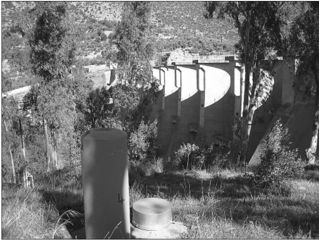
Abb. 2: Blick vom Beobachtungspfeiler 4 auf die Staumauer Beni Bahdel
