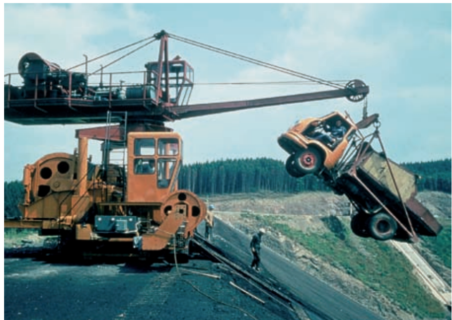
Bild 6: Asphalt-Transport beim Bau des Damms der Biggetalsperre
