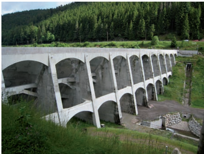
Bild 7: Gewölbereihenstaumauer der Linnachtalsperre
