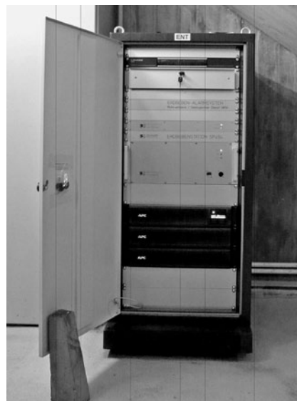
Bild 4: Erdbebenstation der Ennepetalsperre
