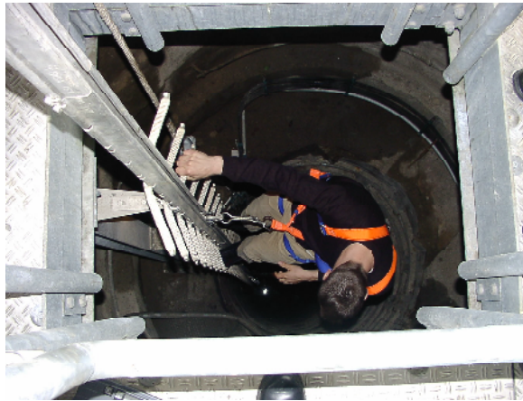
Bild 9: Messung im Inneren des Schieberturms.
