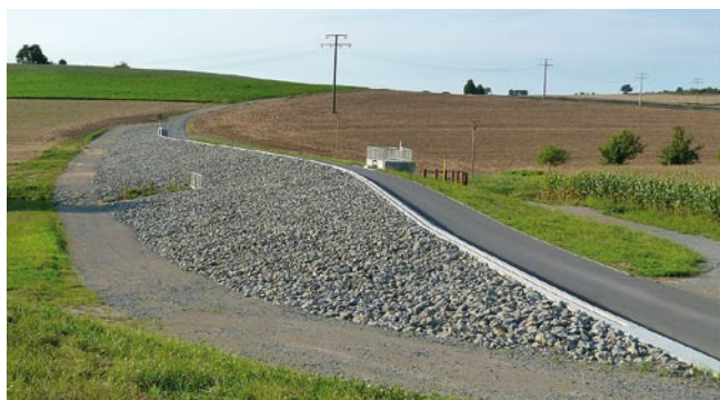
Bild 2: Hochwasserentlastungen: überströmbarer Damm und Stauwand (Bilder: Koch)
